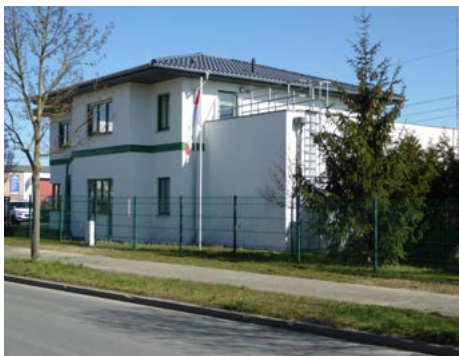
Der Neubau des Bauhofs im Gewerbegebiet. Foto: Ulrich Broniecki
